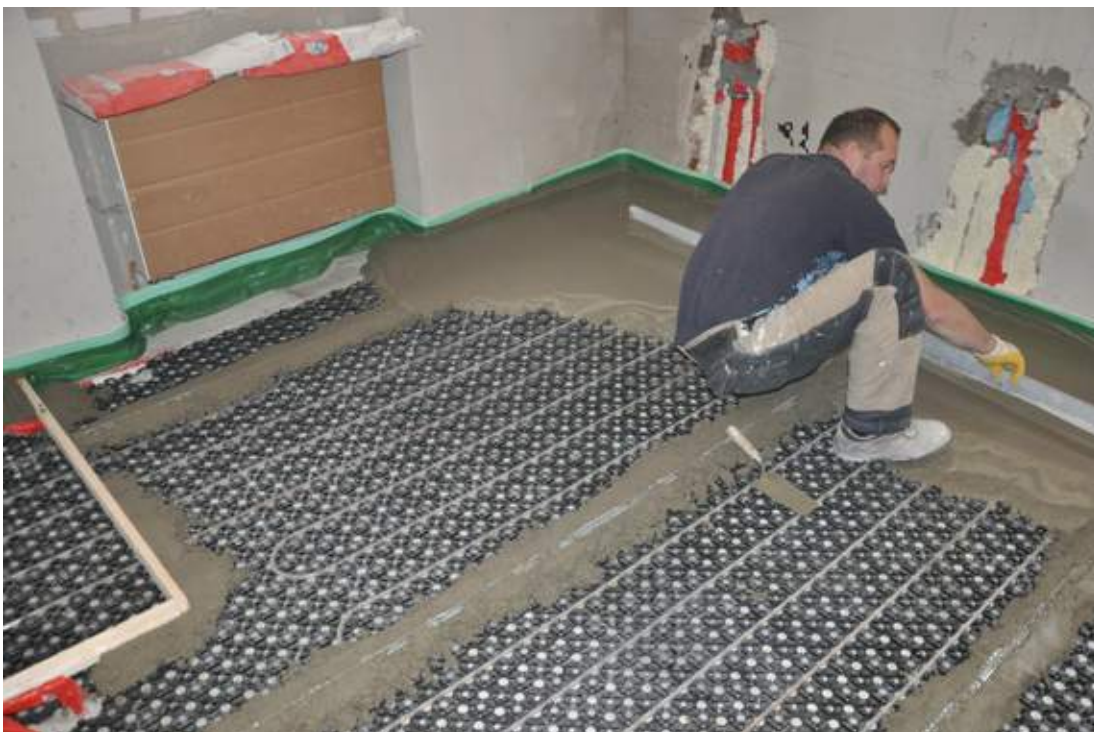
Verlegen einer neuen Fussbodenheizung
