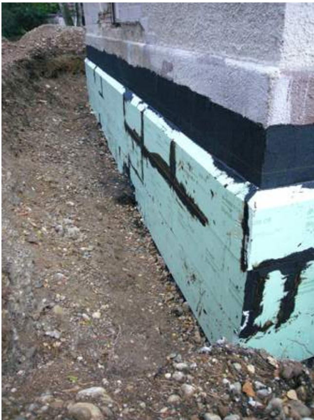
Abdichten und Dämmen der Kelleraußenwände
