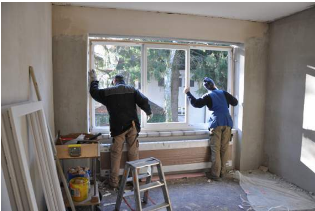
Einbau der neuen Fenster
