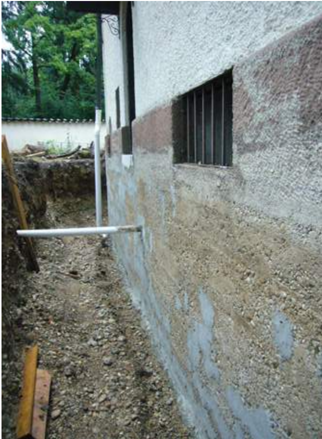
Ausgraben des Kellers und Trockenlegung der Kellerwände
