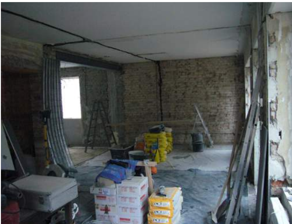
Setzen neuer Elektrokabelkanäle
