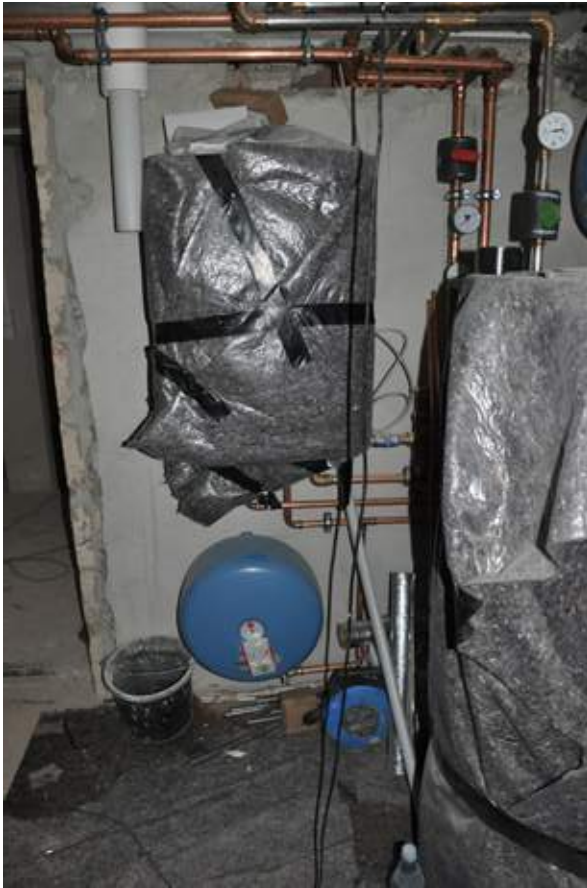
Einbau einer neuen Heizungsanlage - Gasbrennwert
