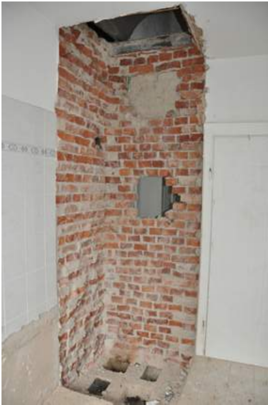
Abbruch des alten innenliegenden Kaminschachtes
