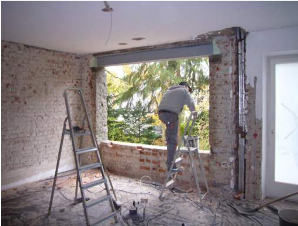
Einbau der Stahlträger für die neuen Fenster und Abschlagen des alten Putzes Einbau neuer Heizleitungsstränge
