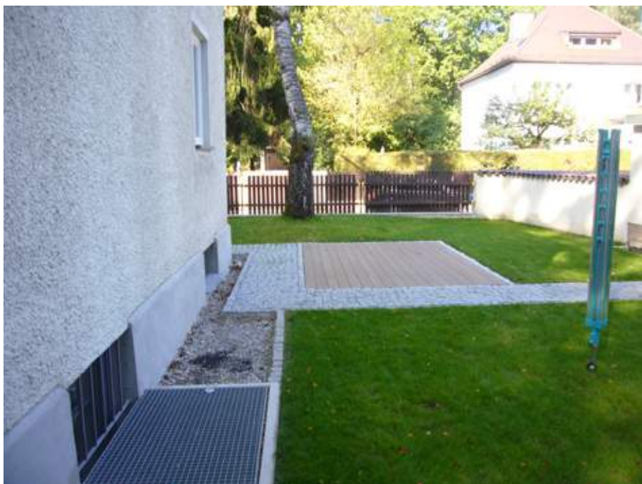
Erstellung neuer Aussenanlagen
