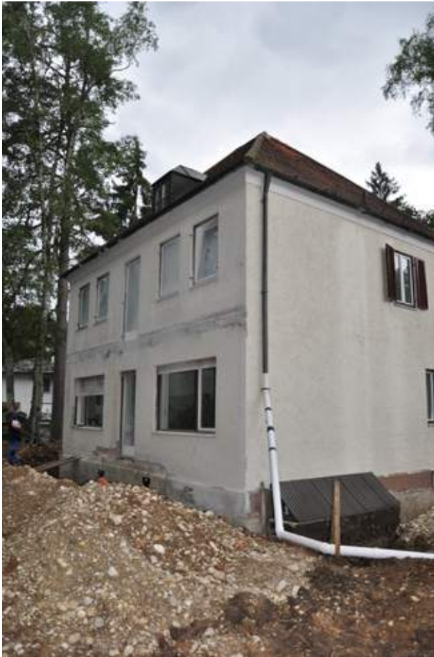
Abtrennung des Balkons
