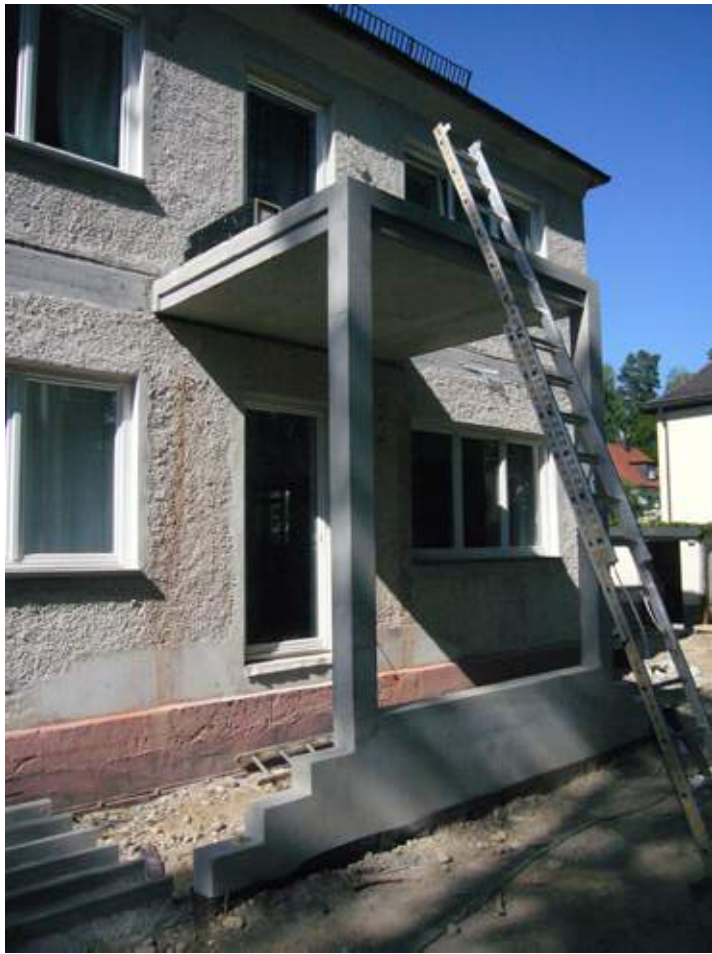
Anbau eines neuen Balkons
