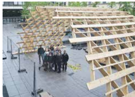
Zollinger-Dach vor dem Nordgebäude der TUM. © Theresa Blömer
